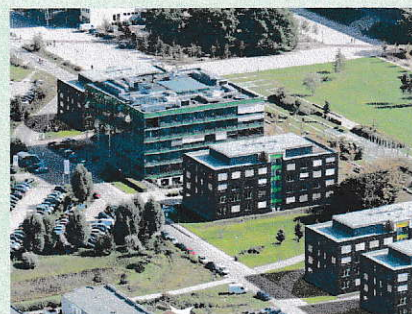
Multifunktionscenter-Gebäude des TZL auf dem BioMedTec-Campus Lübeck
